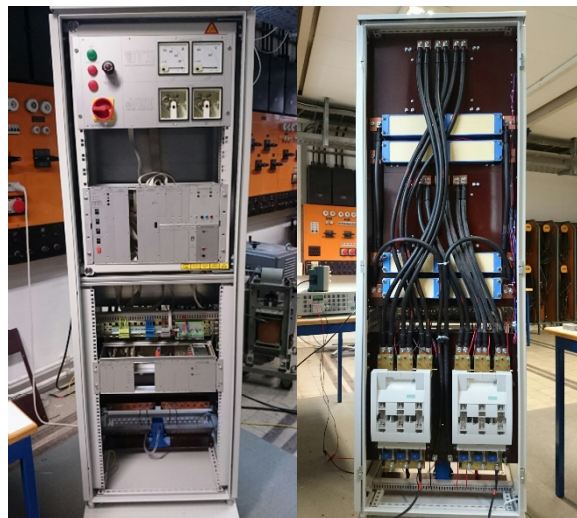
Abbildung: Umrichterschrank der geschalteten Reluktanzmaschine
